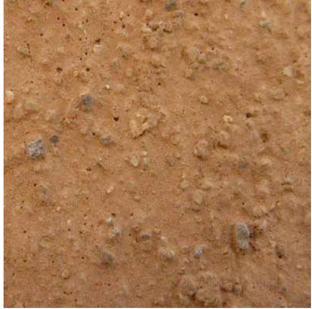
Badigeon recouvrant un enduit à la chaux
