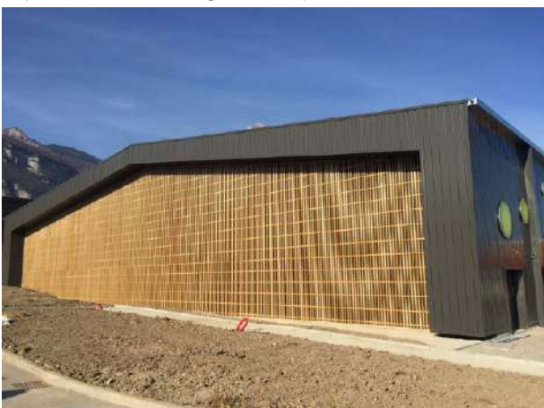
Façade mixte en bardage métallique et bois naturel
