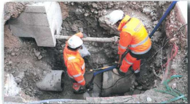
avec une pression d'air sur la paroi intérieure. Une fois la gaine disposée, des lampes UV sont acheminées à travers cette dernière. Elles vont opérer une polymérisation qui va conduire à durcir la gaine. Cela permettra de rendre sa solidité à l'ancien collecteur.
