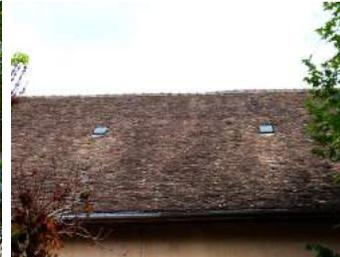
Couvertures en petites tuiles traditionnelles ou en tuiles mécaniques. A droite : recours au fibre ciment.
